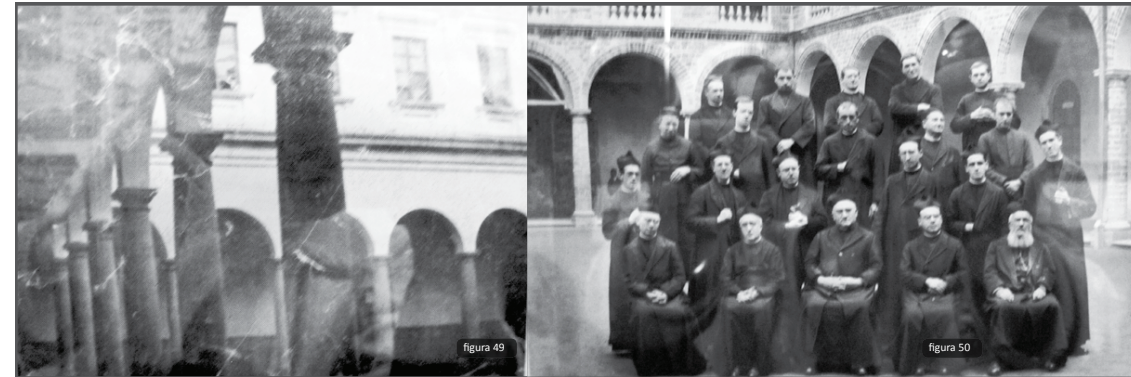
Figuras 49 y 50. Claustros del desaparecido Seminario y del colegio Javeriano, se mantienen tipologías tradicionales heredadas de la colonia. Fuente: Archivo fotográfico del museo Juan Lorenzo Lucero.
